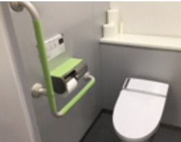
トイレ内の補助手すりに
