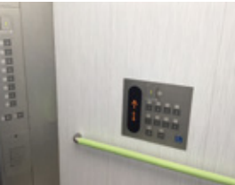
エレベーター内の補助手すりに
